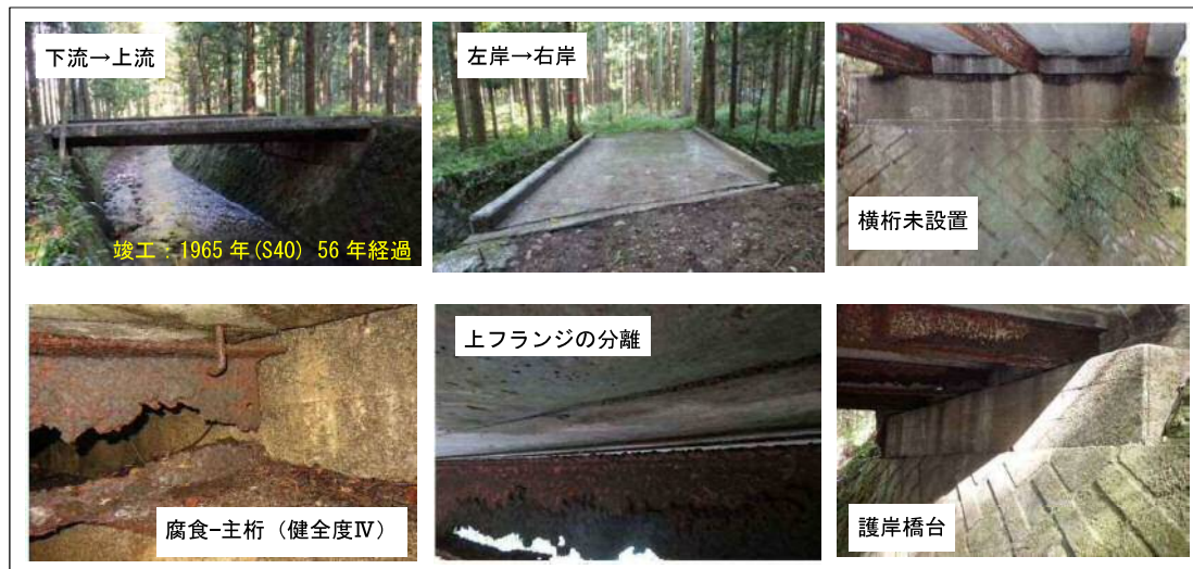
写真 1 架け替え前の橋梁
